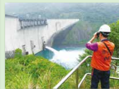
現地檢查（大壩下游側）
