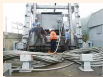
沖刷道鋼纜汰換
