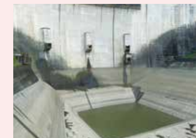
抽乾落水池進行結構安全檢查
