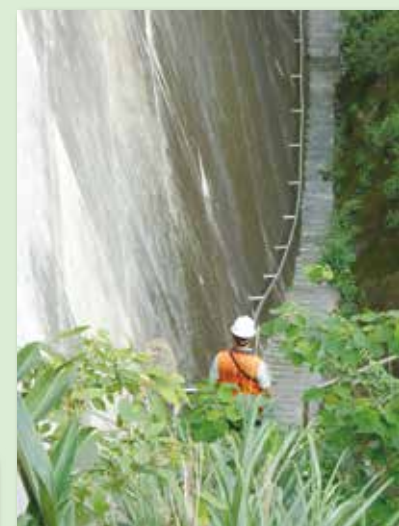
大壩下游鍵槽現地檢查
