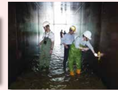
檢查沖刷道鋼襯
